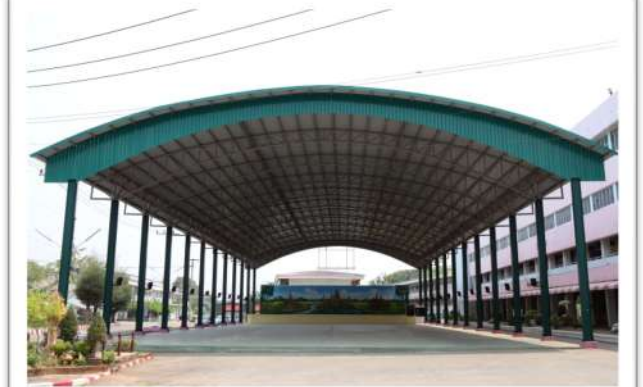
หลังคาคลุมลานอเนกประสงค์
