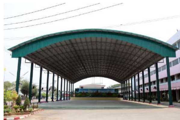
หลังคาคลุมลานอเนกประสงค์
